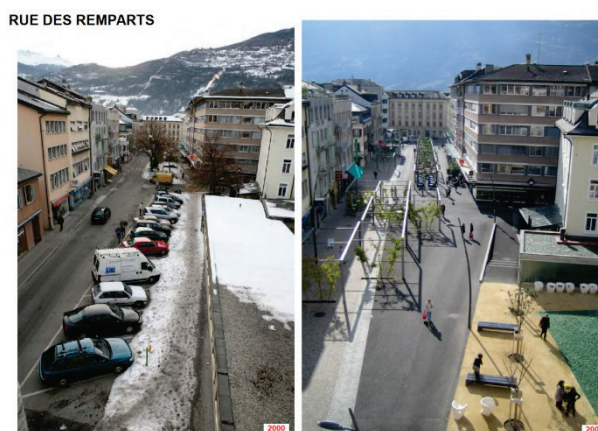
Figure 3 La rue des Remparts à Sion (Suisse)
